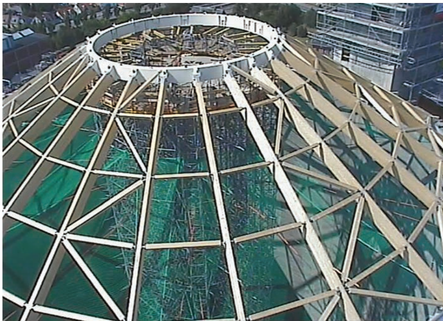
Abb. 8: Dachkonstruktion mit Druckring am Silodom
