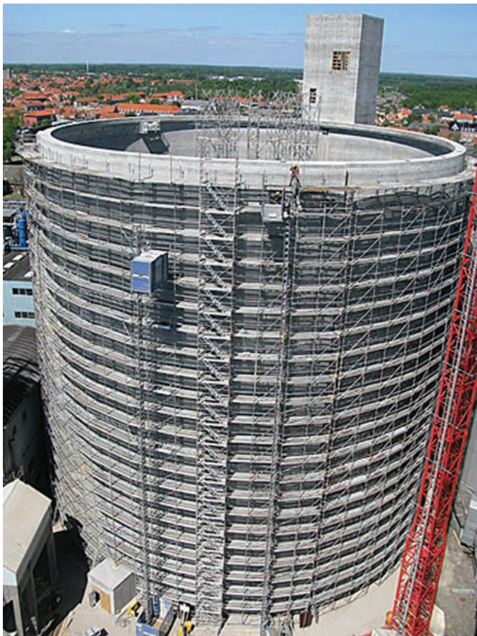
Abb. 7: Silokörper nach Fertigstellung des Gleitbaus
