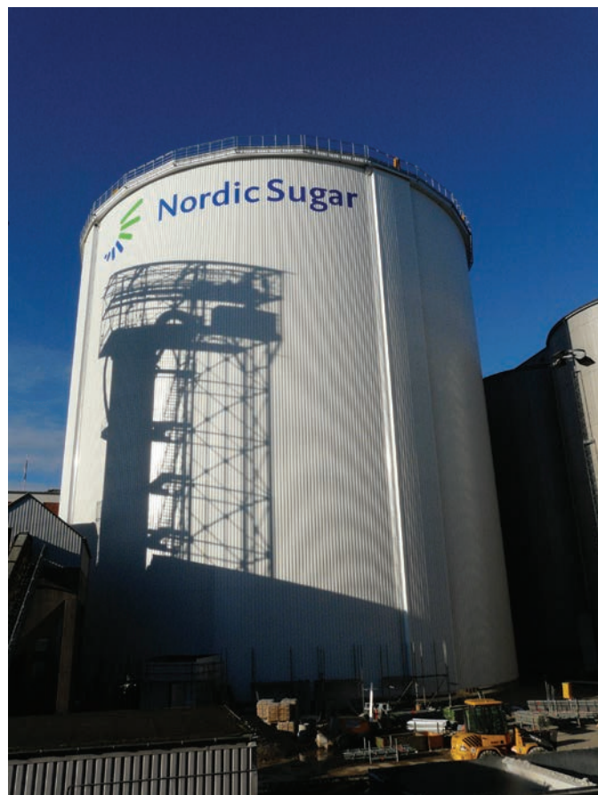
Abb. 1: 60 000-t-Zuckersilo-Neubau
